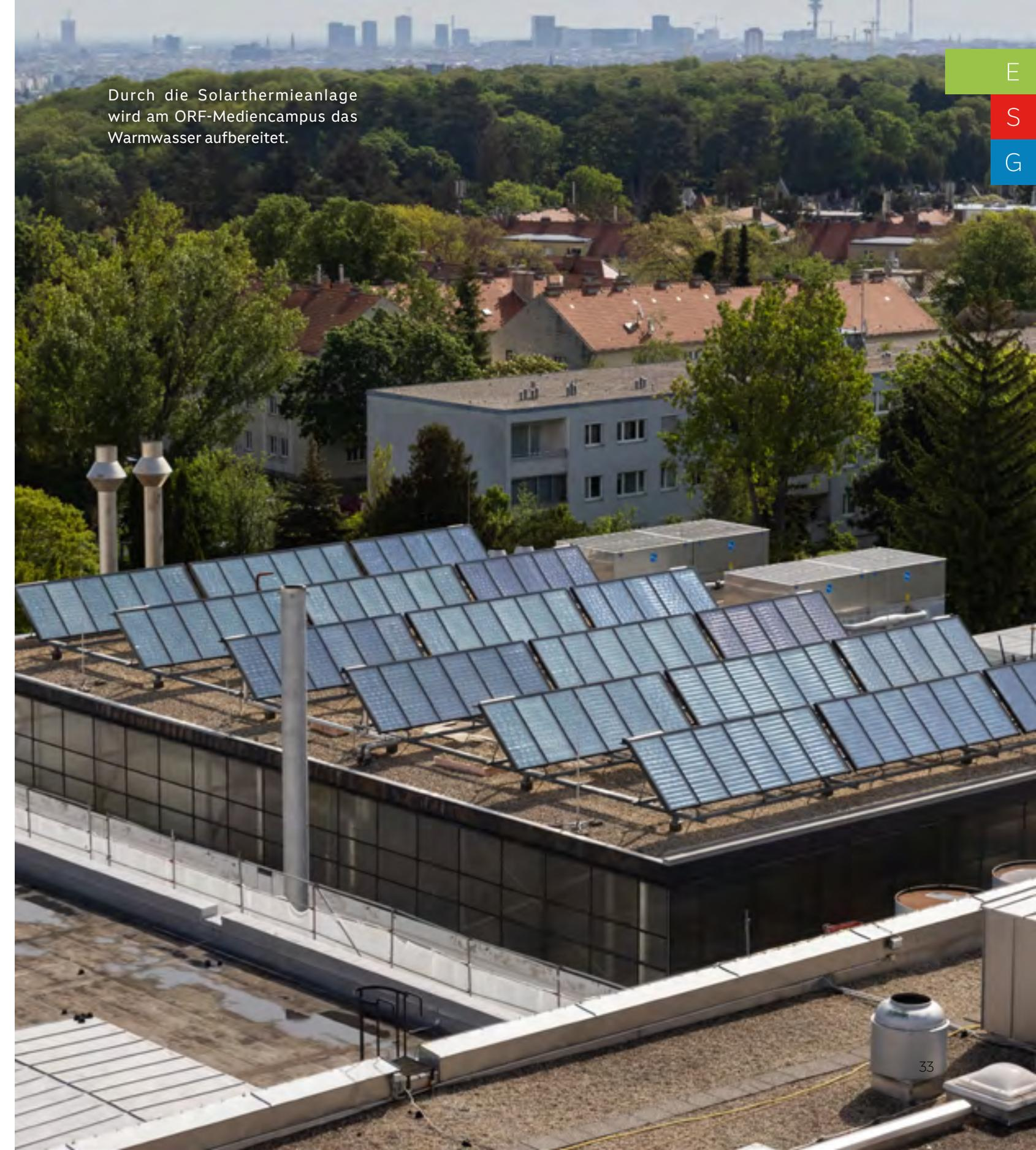
Durch die Solarthermieanlage wird am ORF-Mediencampus das Warmwasser aufbereitet.
